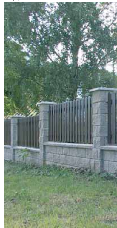
Sloupky z tvarovek 5-11 B 200.
