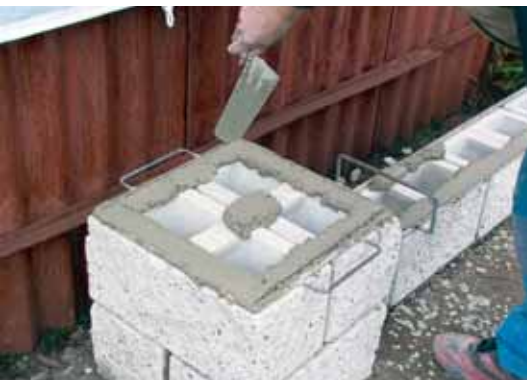
Řada 2: Postup stavby soupu z tvarovky KB 5-11 B.
