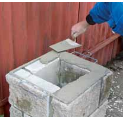
Řada 2: Postup stavby soupu z tvarovky KB 5-11 B.
